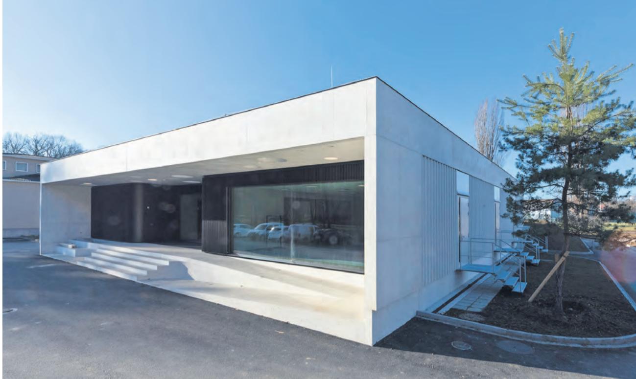
Die neue IWB-Pumpstation kann nun auch öffentlich besichtigt werden.
