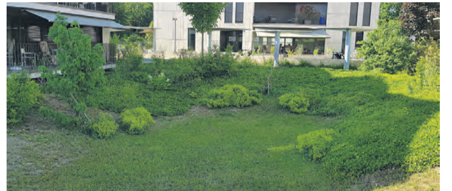
Versickerungsanlage (Typ A) am Kohlistieg, bei der das Regenwasser über die belebte Bodenschicht ins Grundwasser infiltriert.
