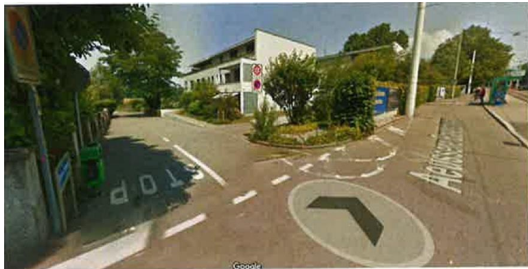
Bild der angesprochenen Kreuzung Aeussere Baselstrasse/Breitmattenweg
