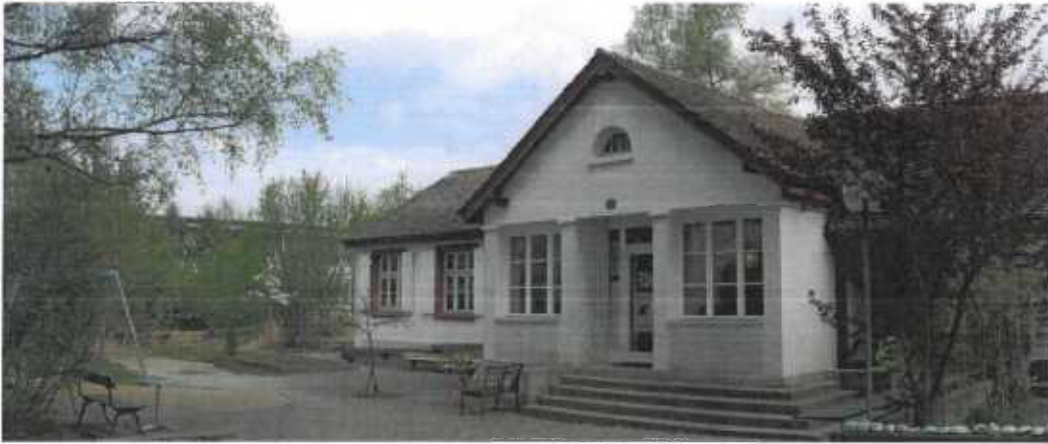
Zugang Kindergarten mit Gartenraum
