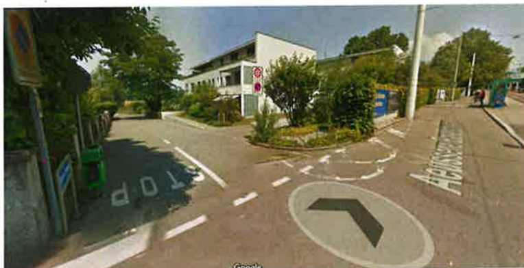
Bild der angesprochenen Kreuzung äussere Baslerstrasse/ Breitmattweg.
