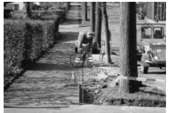
... oder Unterhaltsarbeiten an Trottoirs und Baumrabbatten usw.
