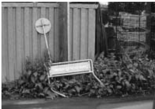
Im Auftrag der «Produktmanager» werden Aufträge ausgeführt, wie das Reparieren von beschädigten Strassenschildern....
