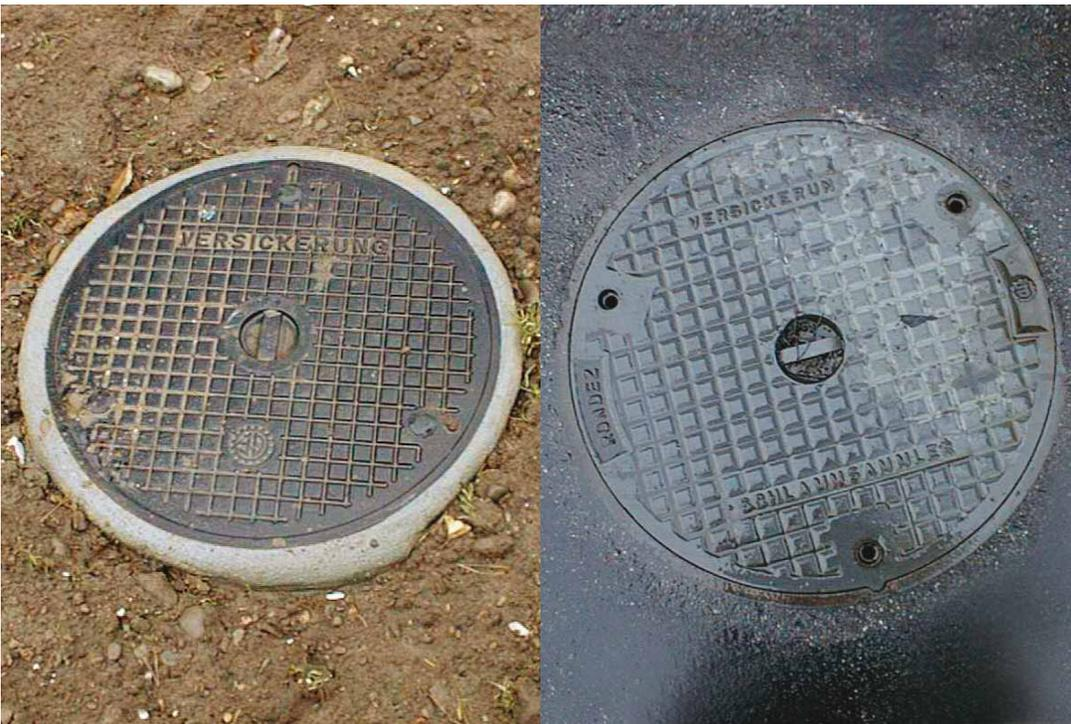
Bild 5: Beschriftungsbeispiel eines Einlaufschachts
