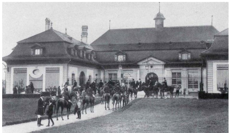
Abb. 2 Historische Aufnahmen der Querachse mit Rond-Point im Vordergrund, der Treillage mit Dressurplatz und der Sattelplatz vor dem Reitstall. Quelle: Clavel 1957.
