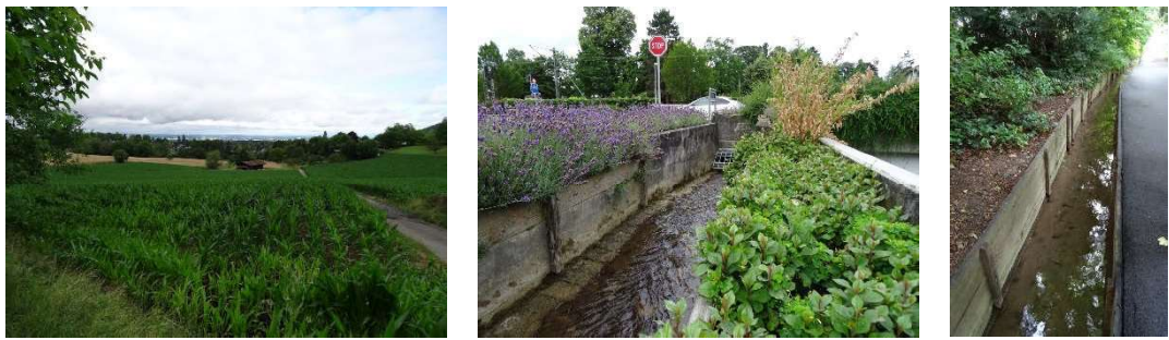
Abbildung 13: Links: Oberhalb der Quelle des Immenbachs in Richtung Riehen; Mitte: Holzkastenverbau im Bereich Durchlass Eisenbahnweg; Rechts: Holzkastenverbau im Bereich Wettsteinanlage
