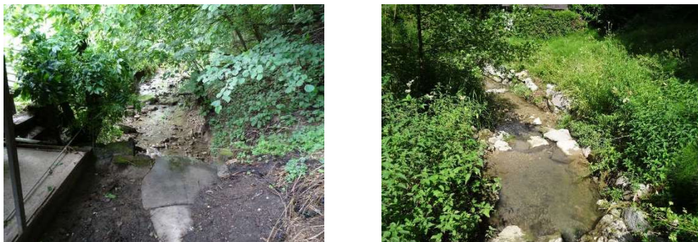
Abbildung 14: Links: Durchlass im Bereich Bauernhof im Autorial; Rechts: Bachlauf im Bereich des Weihers im Autorial
