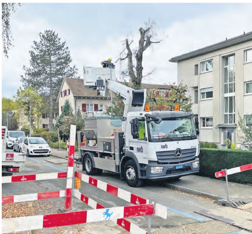
IWB-Monteur bei der Montage der LED-Leuchten.
